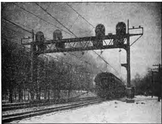
Fig. 14. Position Light Signals, P. R. R.
