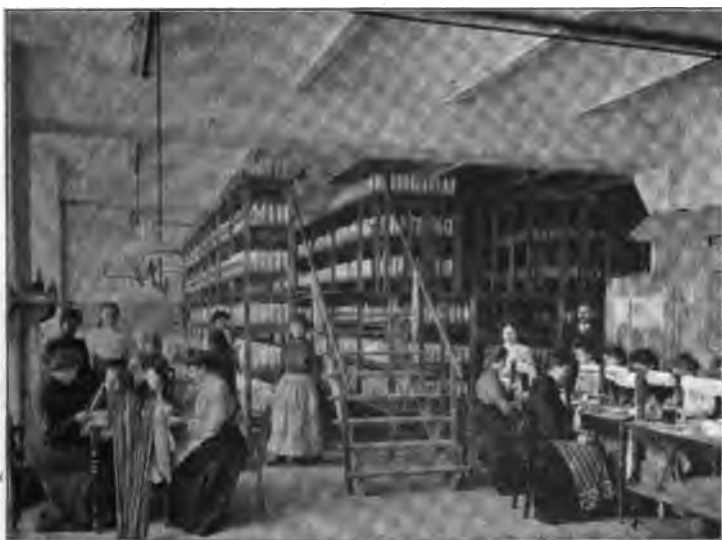
Fig. 69. Trockenraum für die imprägnierten Strümpfe.
