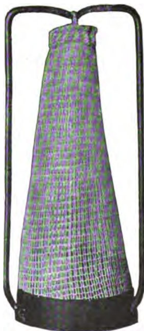
Fig. 157. Aufhängung für Petroleumglühkörper, d. heute meist durch zentrale Befestigung ersetzt ist.
