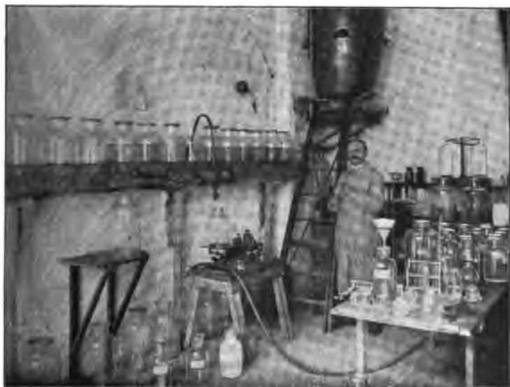
Fig. 66. Raum für die Herstellung und Aufbewahrung der Leuchtflüssigkeit; sog. Laboratorium der Glühkörperfabriken.
