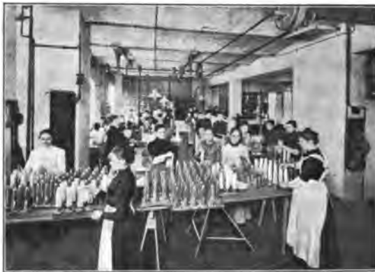
Fig. 70. Trockenraum für die imprägnierten Strümpfe. Im Vordergrunde Bretter mit Trockengläsern.
