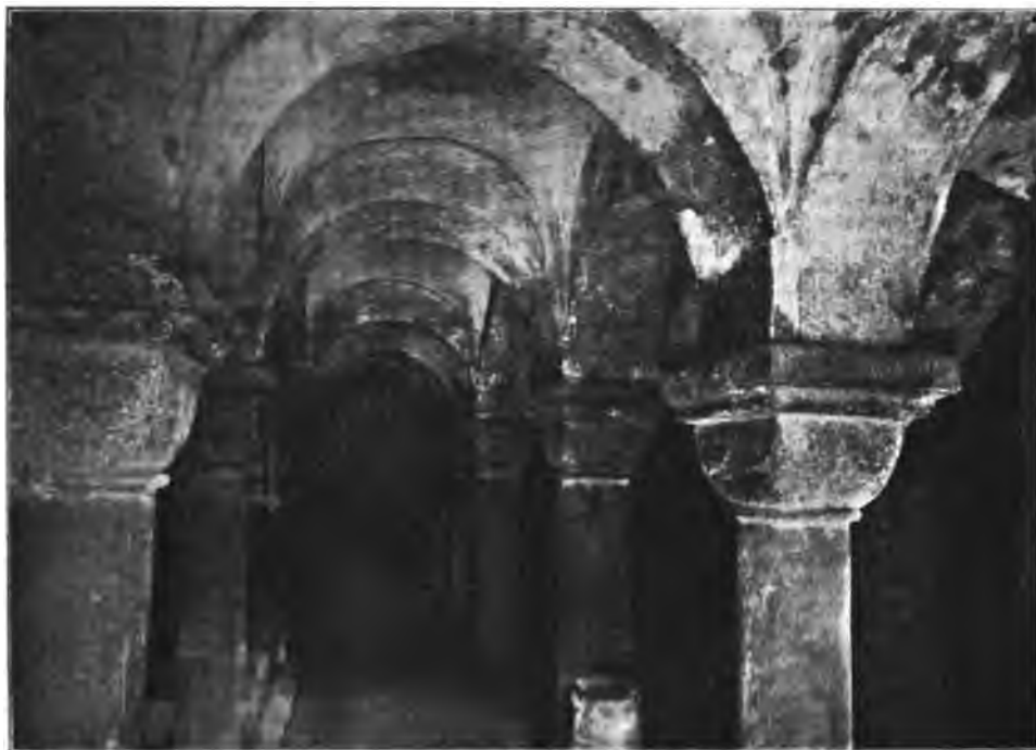
Fig. 111. Oberpleis, Propstkirche. Inneres der Krypta vor der Herstellung.
