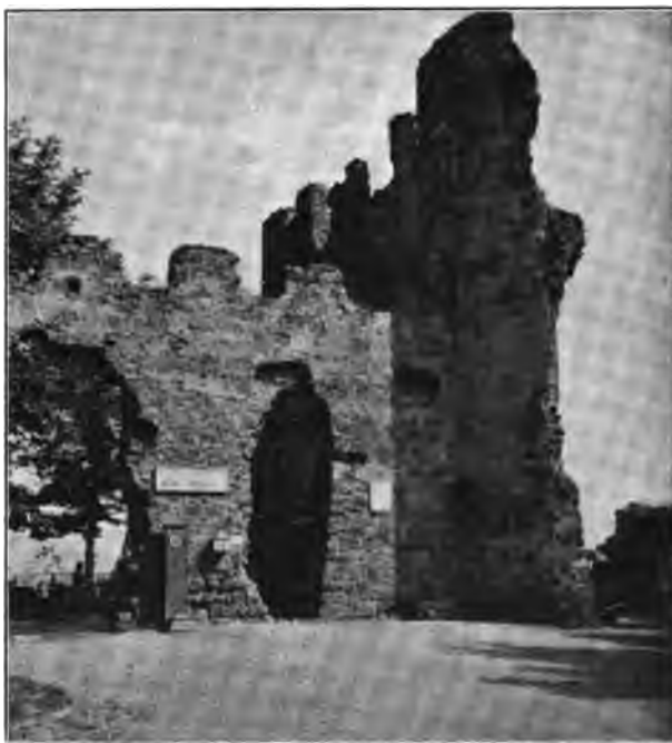
Fig. 192. Godesberg. Der Treppenturm am Palas.
