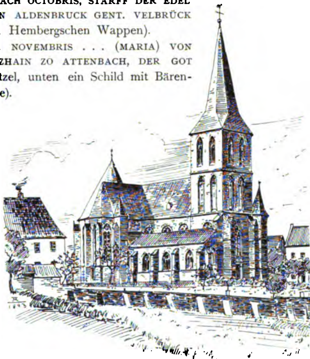
Fig. 19. Bödingen. Ansicht der kathol. Pfarrkirche mit dem jetzigen Chordach.
