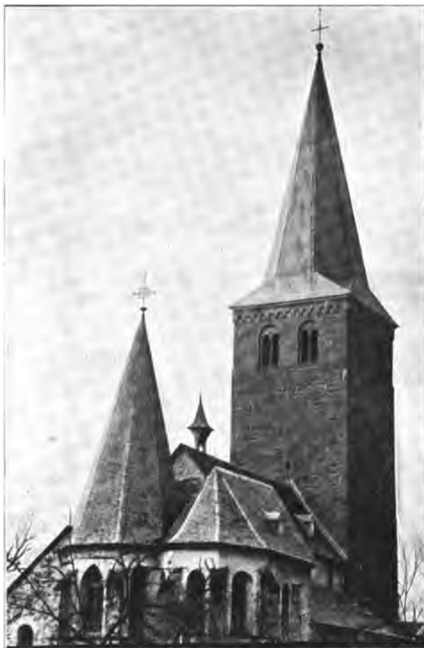
Fig. 119. RuppichterOTH. Ansicht der kathol. Pfarrkirche vor dem Neubau des Langhauses.
