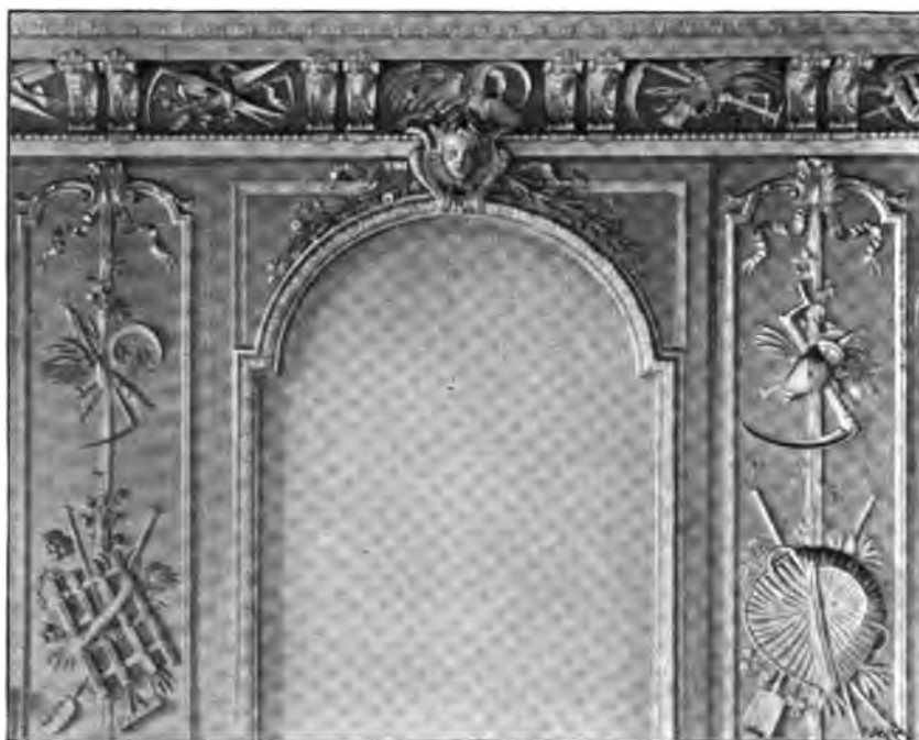
Fig. 161. Poppelsdorf, Schloss. Detail aus dem Appartementssaal.
