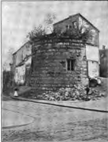
Fig. 92. Bonn. Ehemaliger Mauerturm der Nordseite.
