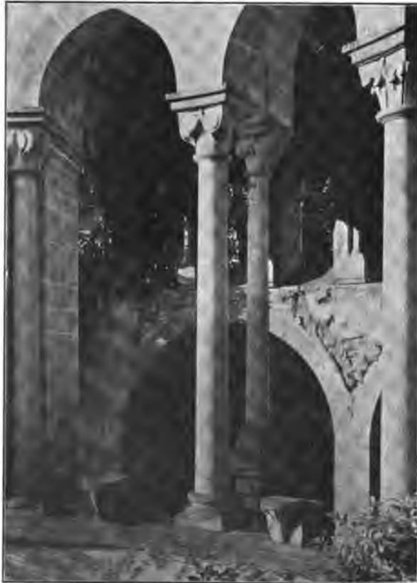
Fig. 38. Heisterbach, Chorrune. Säulenstellung des Umganges.
