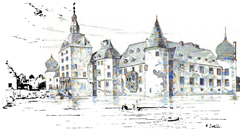
Fig. 201. Gudenau. Ansicht der Burg von der Nordseite.
