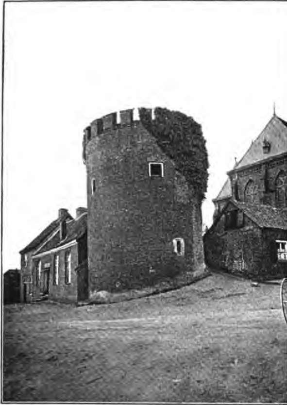
Fig. 44. Isselburg. Rundturm der ehemaligen Befestigung.
