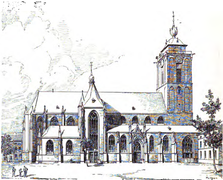
Fig. 5. Duisburg. Nordansicht der Salvatorkirche.
