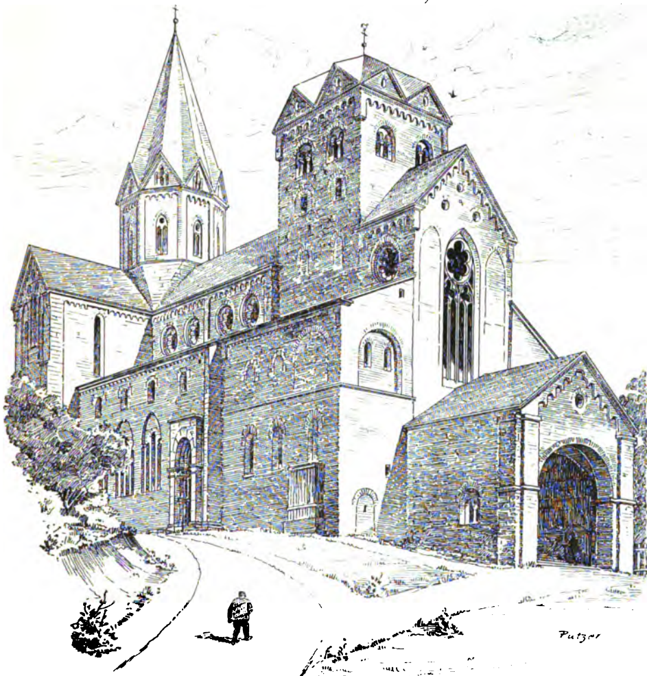
Fig. 36. Werden. Nordwestsicht der Abteikirche.
