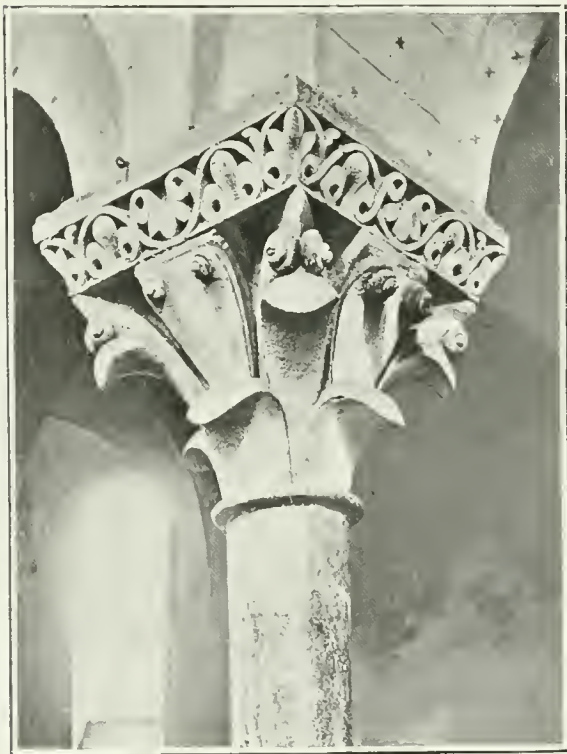
SAINT-SEVER. — Église. Chapiteau du transept.
