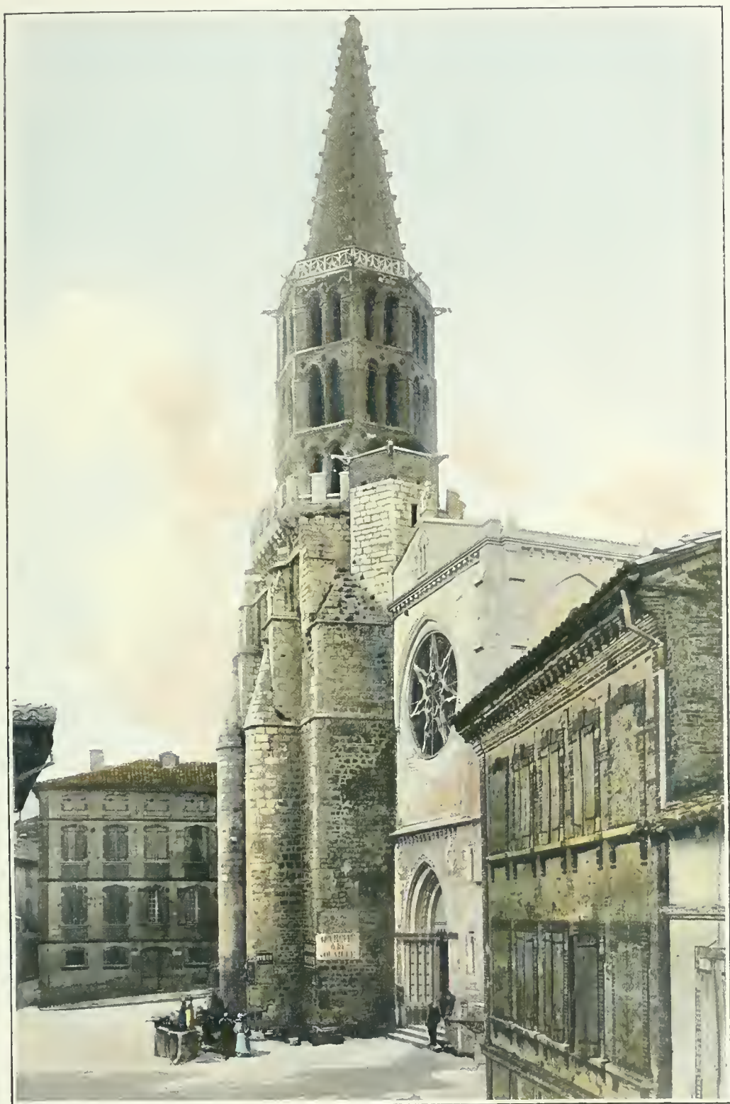
CAUSSADE. — Église. Façade O.
