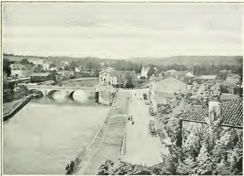
CONDOM. — Vue générale.
