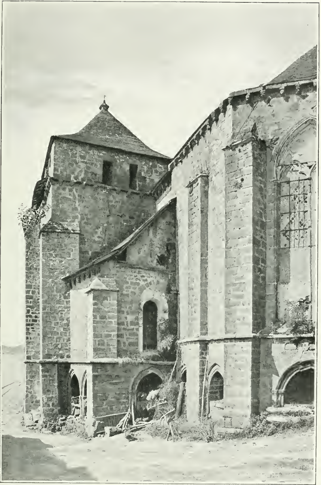
AYEN. — Église, Ensemble S. E.
