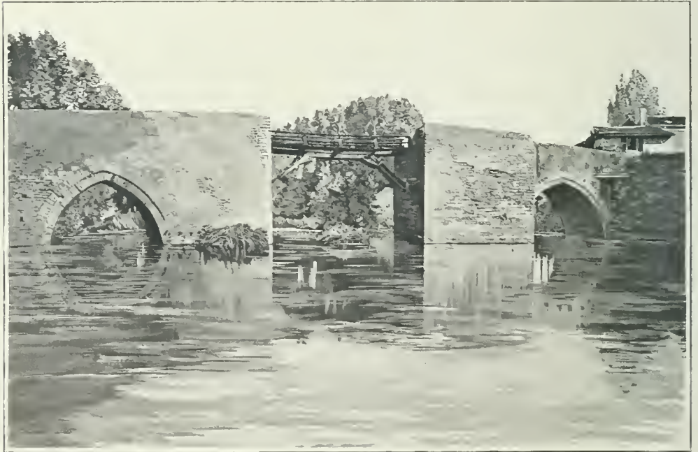
THOUARS. — Vieux pont sur le Thouet. Vue aval.
