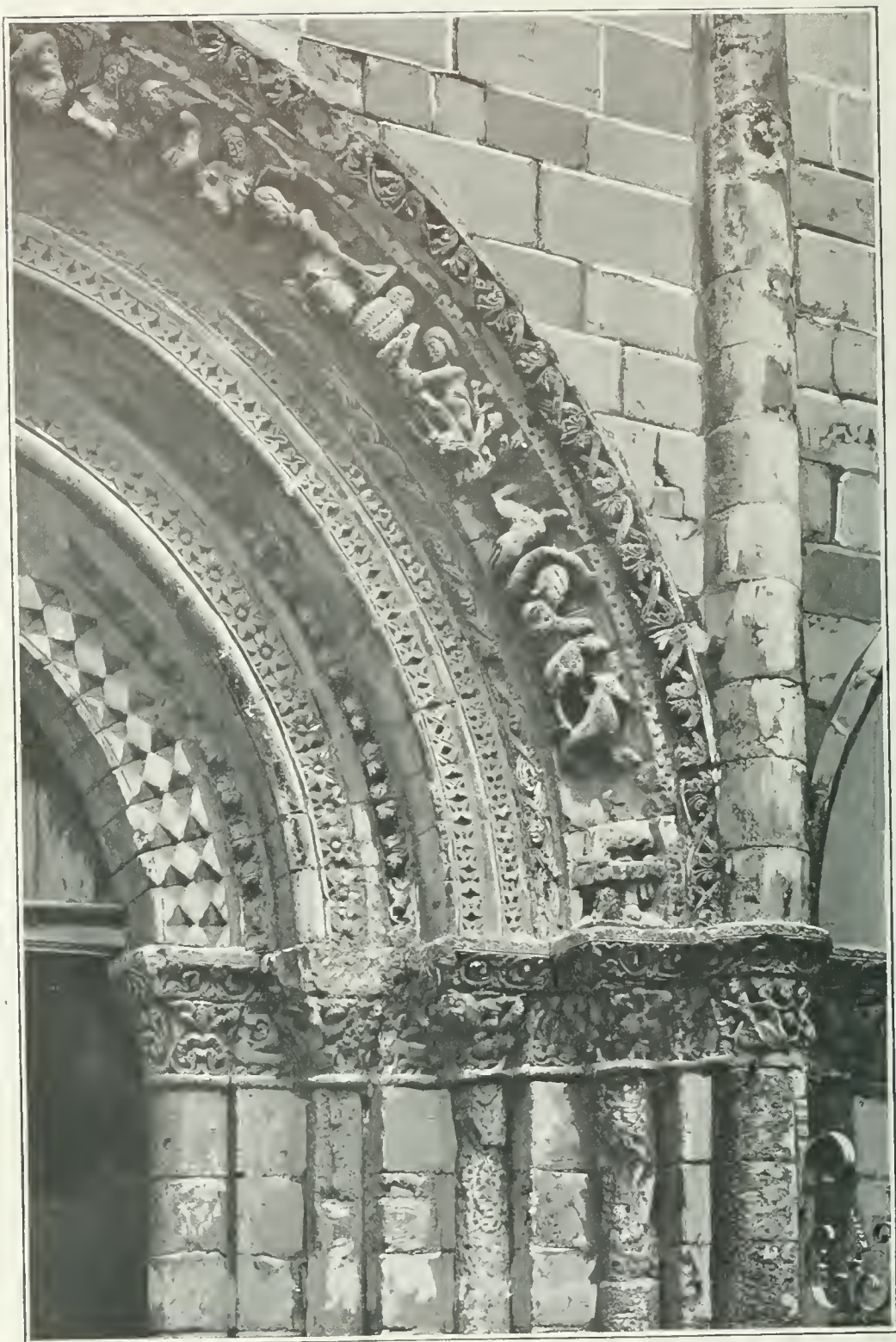
COGNAC. — Église St-Léger. Façade O. Porte centrale. Fragment de droite.
