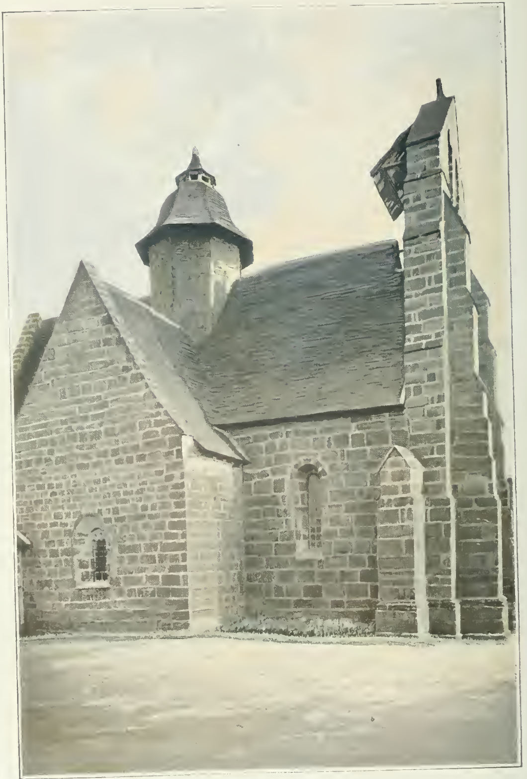
SAINT-CYR-LA-ROCHE. Église. Ensemble N.
