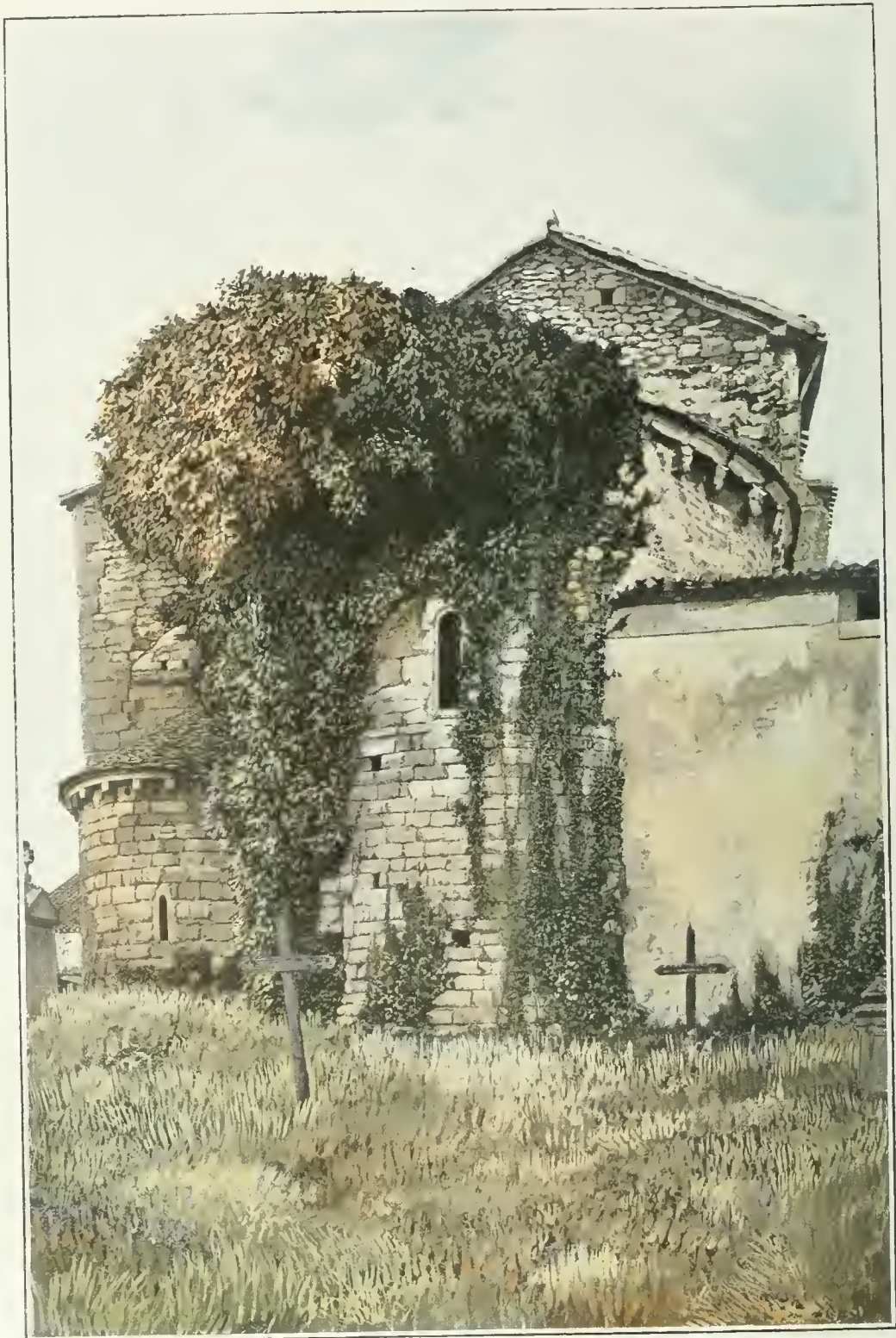
SAINTE-CROIX. - Église. Abside.
