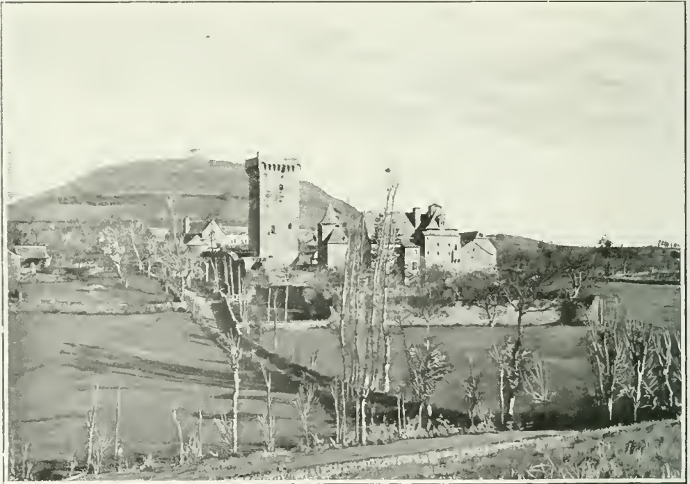
GABRIAC. — Château et Tour féodale de Tholet.
