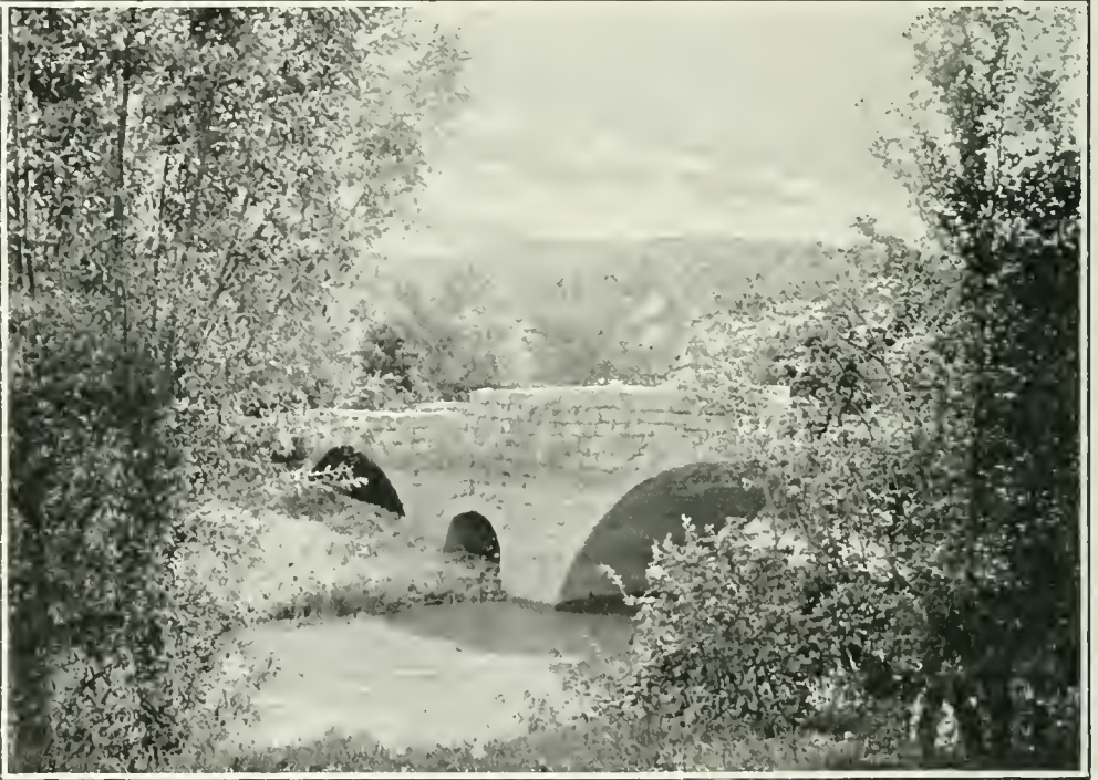
ARTIGUES. — Pont sur l'Osse.
