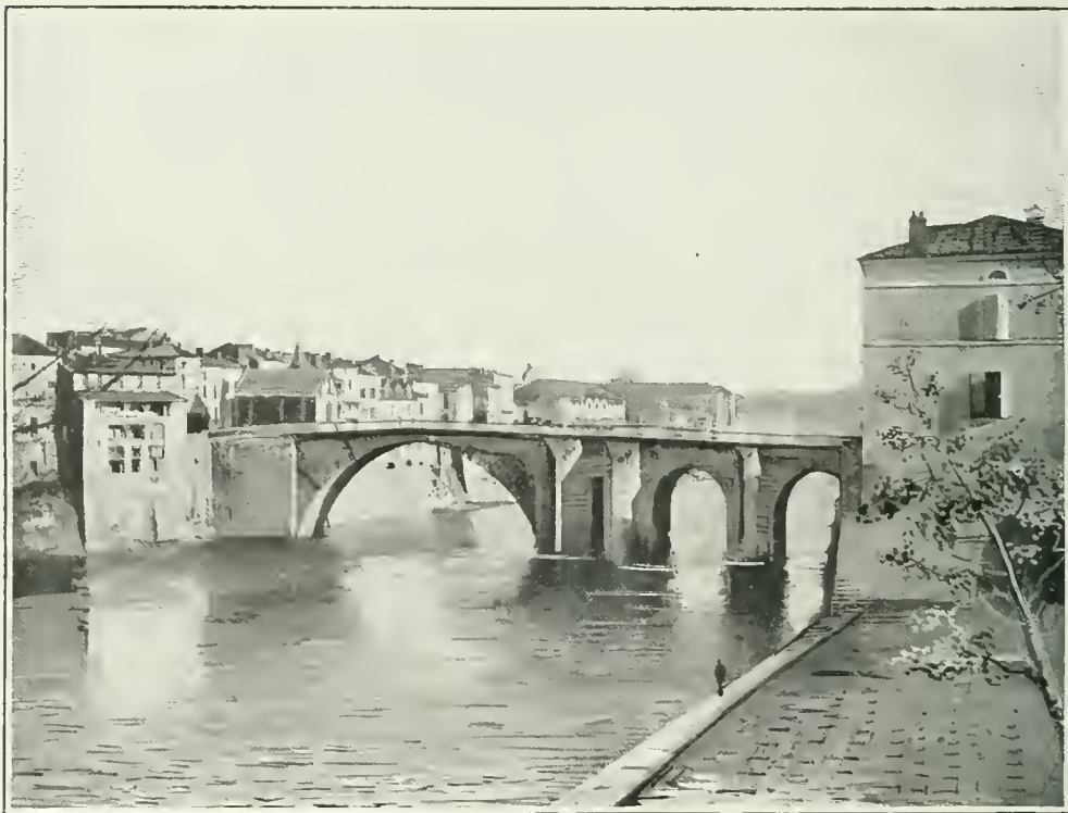
VILLENEUVE-SUR-LOT. — Vieux pont sur le Lot.
