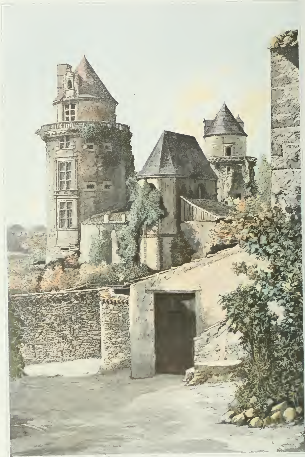
APREMONT. — Château. Four d'angle et Chapelle.
