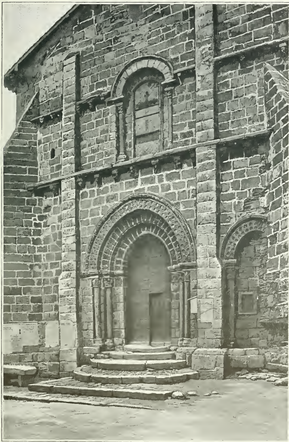
PRESSAC. — Église, Façade O.
