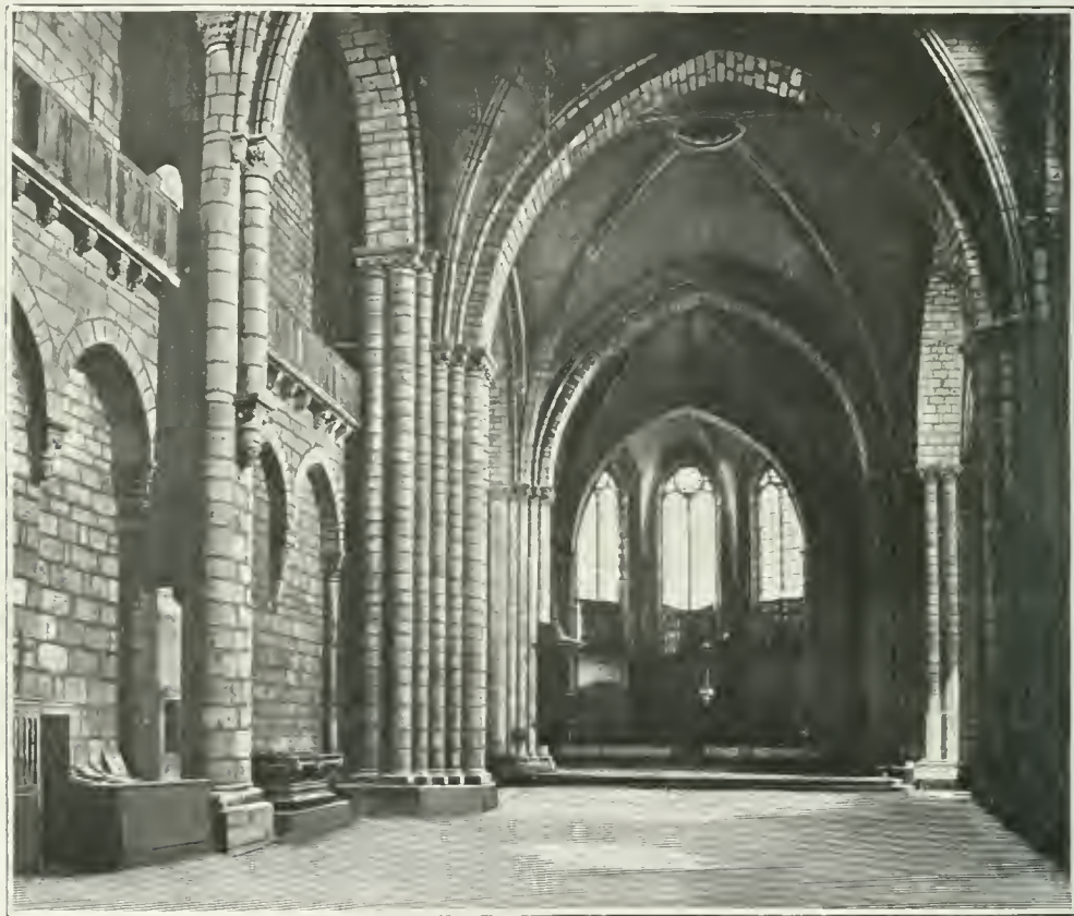
SAINT YRIEIX. - Église. Nef, vue prise de l'entrée.
