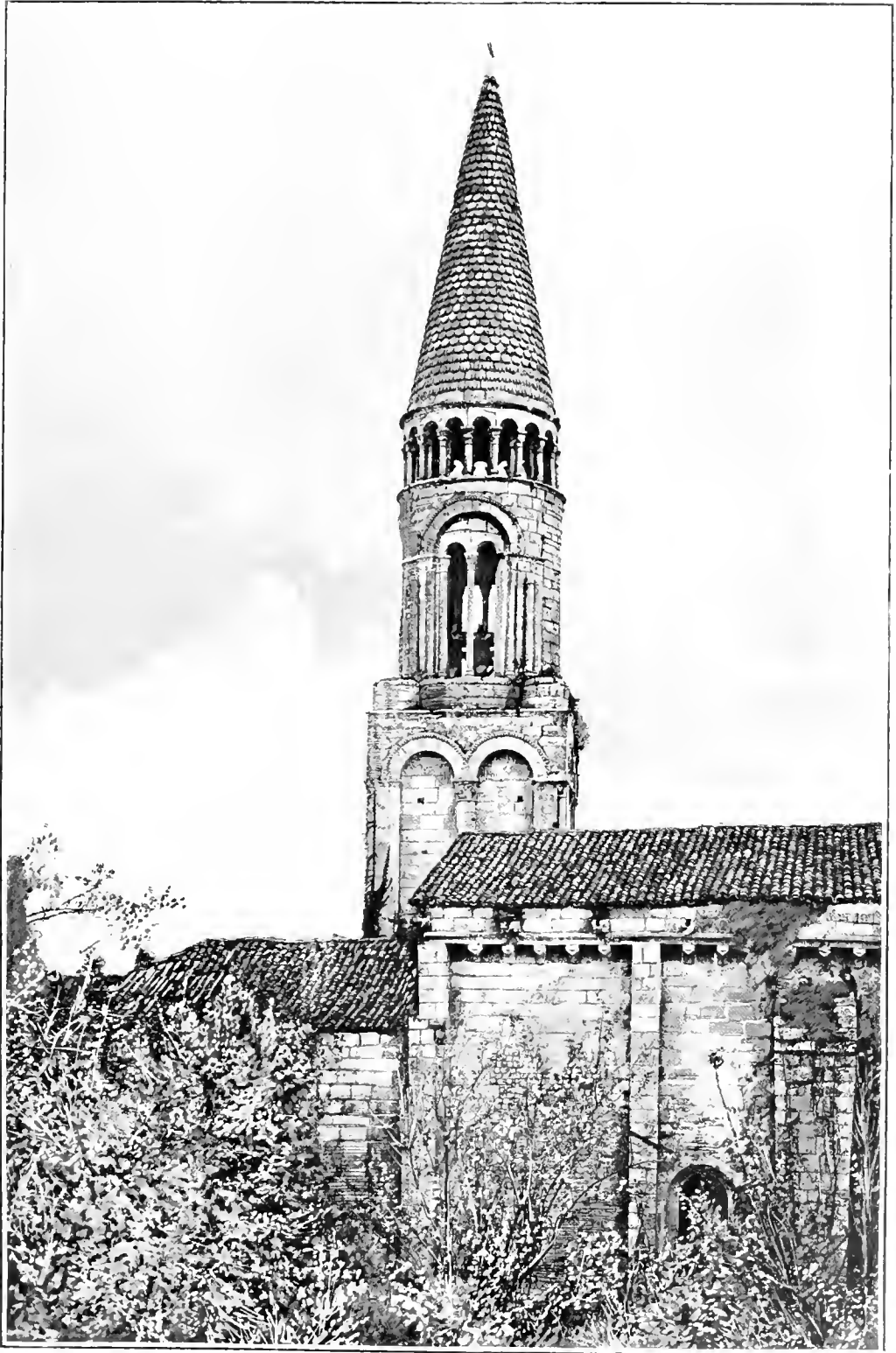
FÉNIOUX. — Ancienne abbaye. Clocher de l'église.
