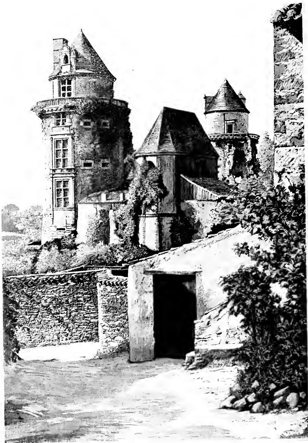
APREMONT — Château. Tour d'angle et Chapelle.
