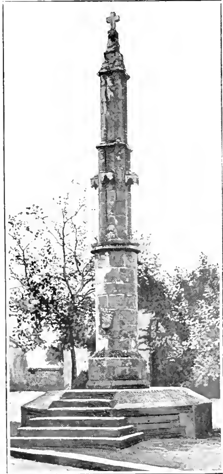
CHERMIGNAC. — Croix de l'ancien cimetière.
