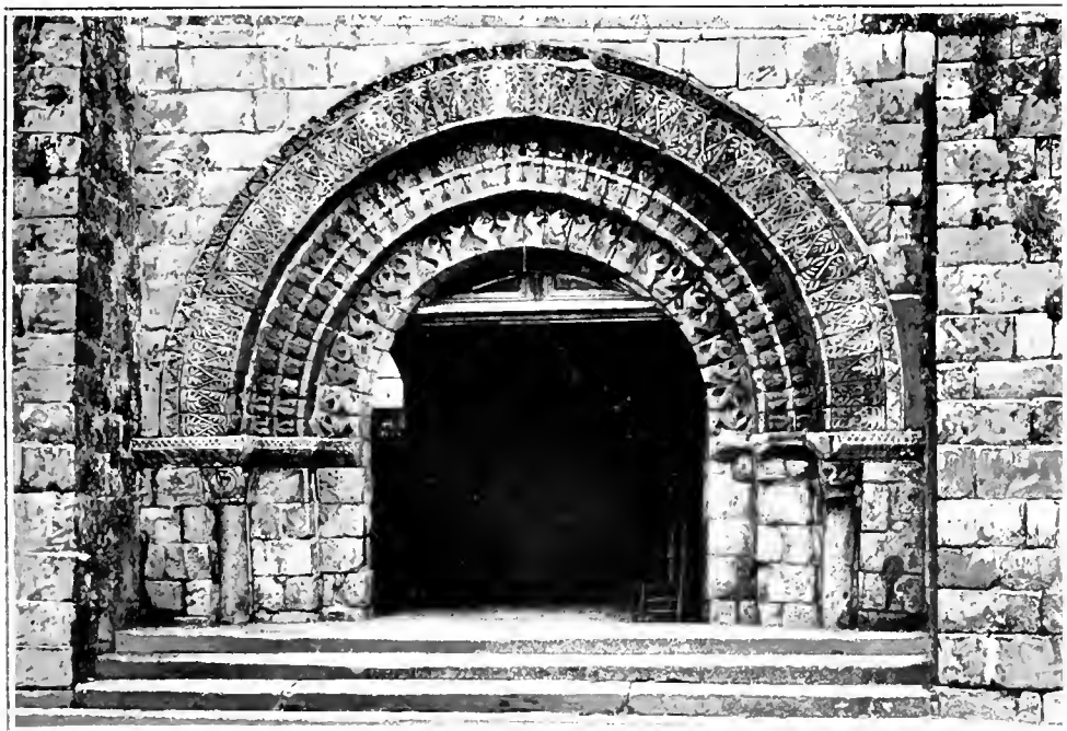
SAINT MAURICE. — Église. Portail N.
